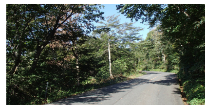
危険木の除去（作業後）
