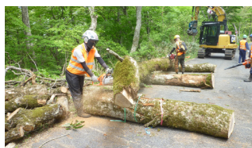
危険木の除去（作業中）
