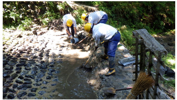
防火貯水槽の取水口に溜まった土砂の撤去
