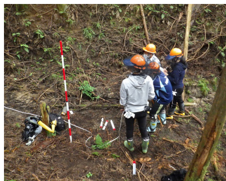
【治山工事予定箇所の測量】
