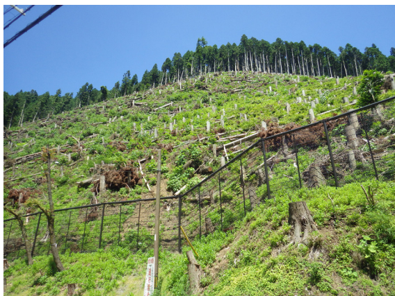
【落石防護柵設置、風倒木処理後】
