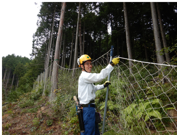
【防護柵を点検中】
