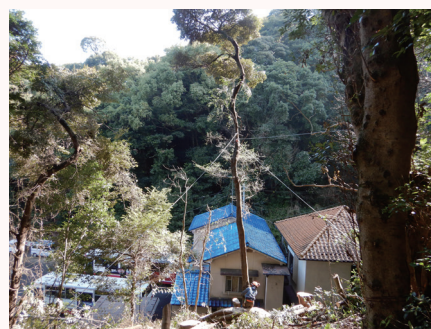
【ワイヤーで倒れる方向を規制しながらの伐倒作業】
