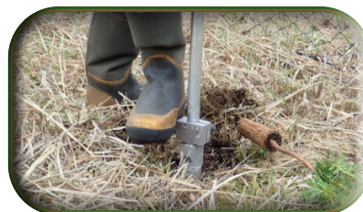
【植栽する穴を開けます】
