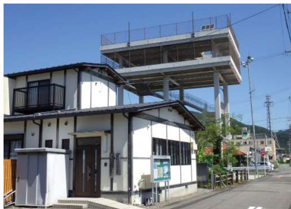
合同事務所と津波避難タワー
