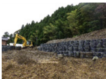
被害箇所の応急対策 実施状況（石川県珠洲市）
