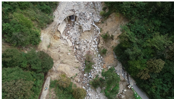
ドローンによる被災箇所の確認
