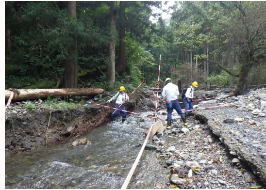
被災した林道のセンターの横断測量 滝ヶ谷林道（南越前町）
