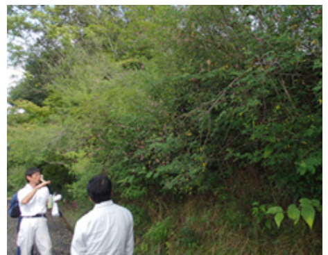
緑化対策後の法面遷移の様子
