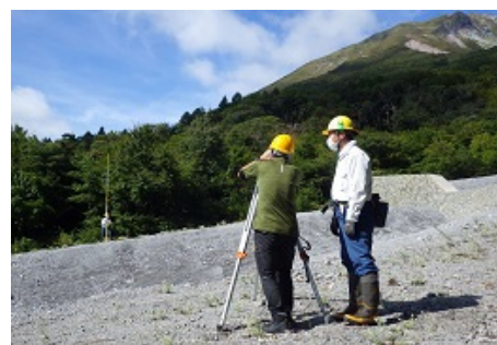
治山工事調査の様子
