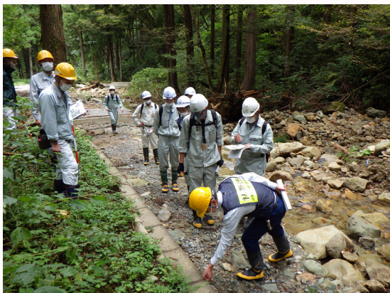
被災した林道の復旧に向けた技術指導 （白山市）
