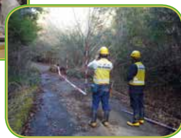
被災箇所の調査の様子
