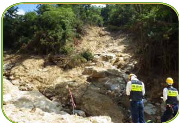
被害地を調査し復旧計画を検討 35度を超える猛暑日が続く中で、調査を実施 嵩山国有林（広島県 熊野町）
