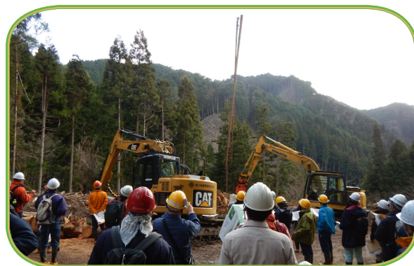
架線集材の様子
