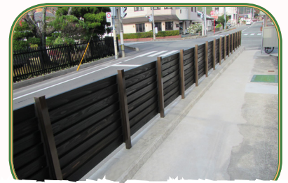
木製の塀に改修（山口森林管理事務所）
