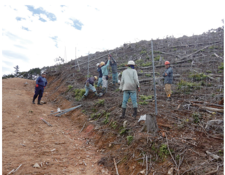
鋼製ネットの設置作業
