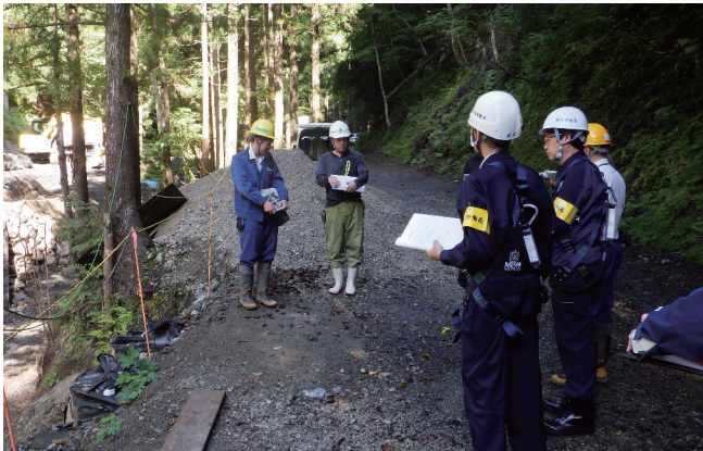
安全パトロールの様子（工事箇所の確認）
