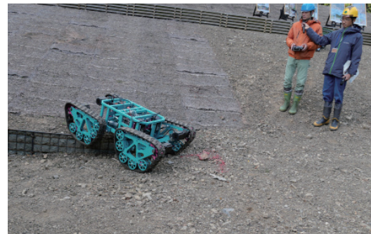
(エ)4 輪車走行の様子
