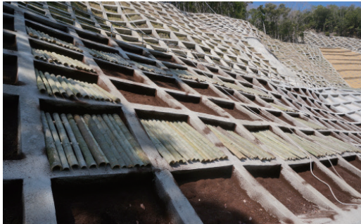
(ア)竹を使用した新たなシカの侵入防止対策、施工当時の様子（平成 30 年撮影）
