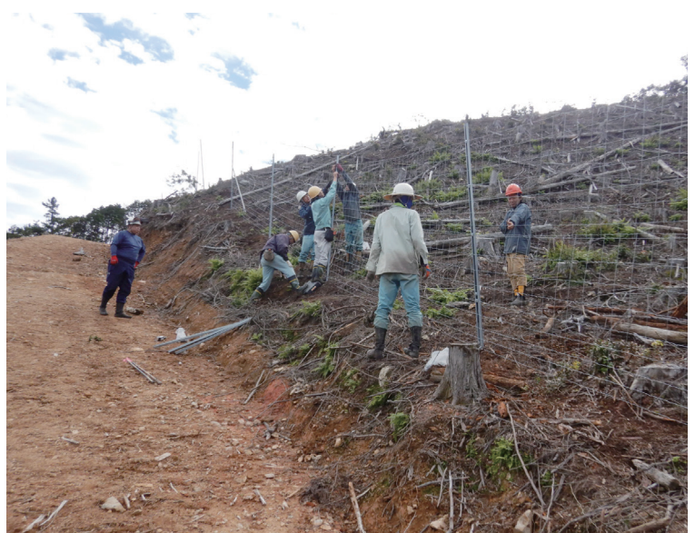
鋼製ネットの設置作業
