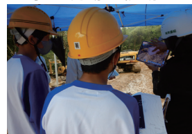
治山工事現場の見学
