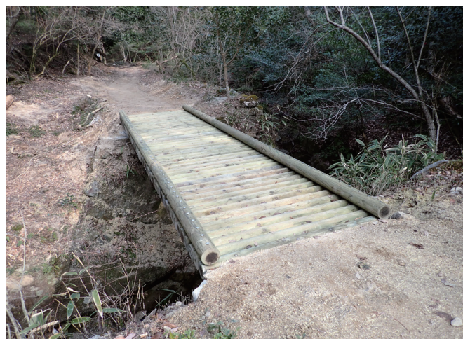
遊歩道（整備後）（一丈野国有林）
