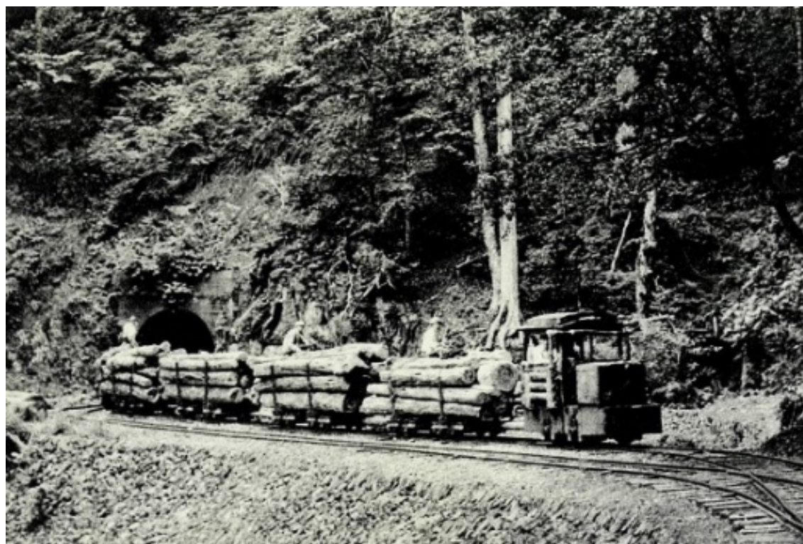
森林鉄道（20林班湯川隧道西口を出る運材列車、昭和18年）
