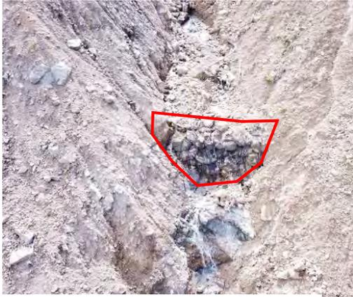
写真－7 袋型石詰筋工
