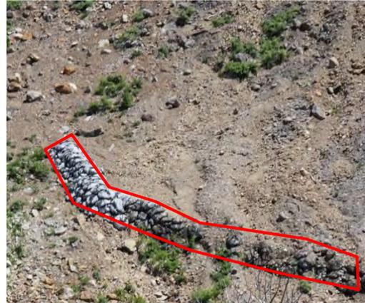
写真－8 袋型石詰筋工
