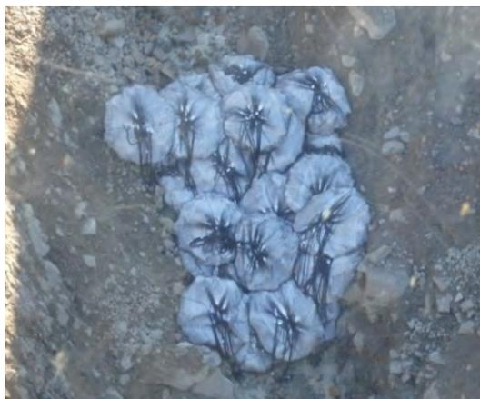
写真－3 袋型石詰筋工
