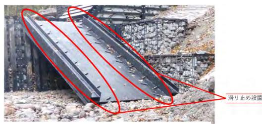
写真-2 滑り止め設置状況
