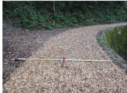
写真-4 試験施工完了
