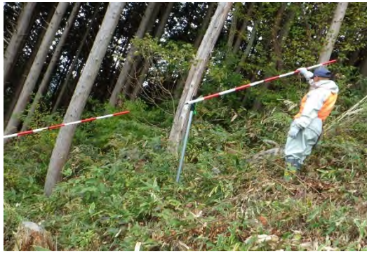
写真-16 倒木による柵体の脱落
