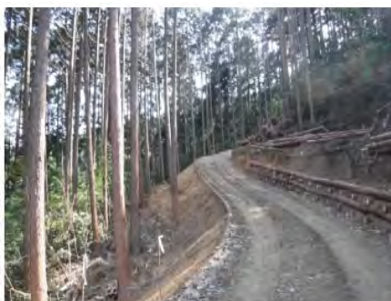
片勾配+木製路面排水工 (奈良県吉野郡)
