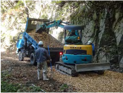
写真-3 敷均し状況
