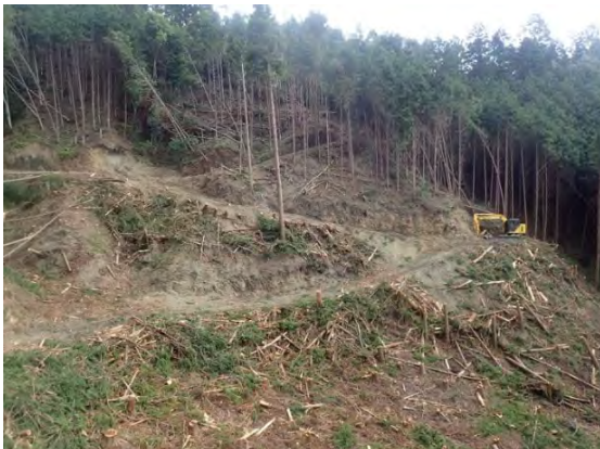
写真－４ 国有林内作業道作設状況
