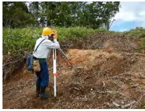
写真-1 TS 測量
