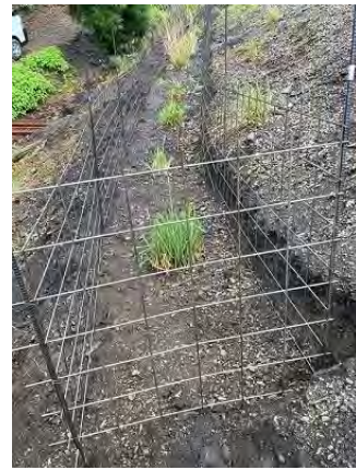
写真-4 設置状況
