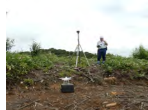
写真-5 RTK 計測
