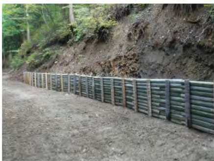
山側土留工 (和歌山県田辺市龍神)
