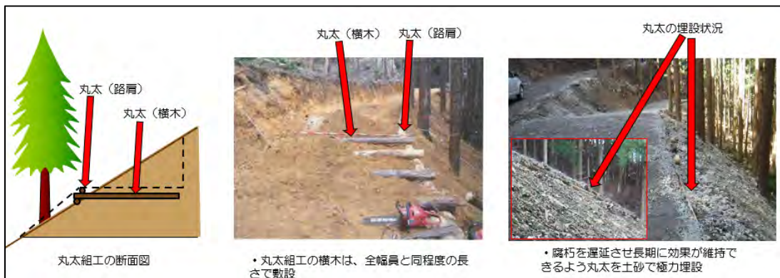
写真2 丸太組工（従前から取り組んできた工法1）
