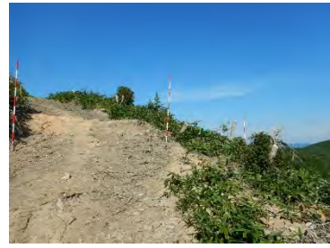
写真-10 No.2 横断面谷側
