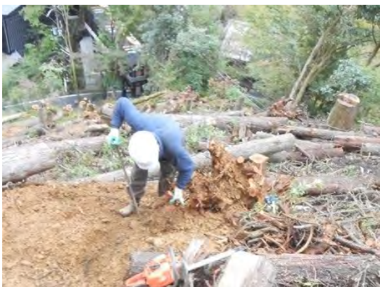
写真-16 根株の根切り、土砂撤去作業
