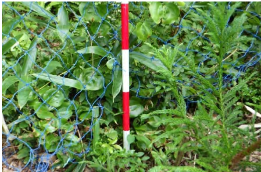
写真－10 ネットの継ぎ方不良
