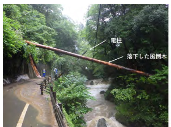
写真－７ 道路周辺施設の被害状況
