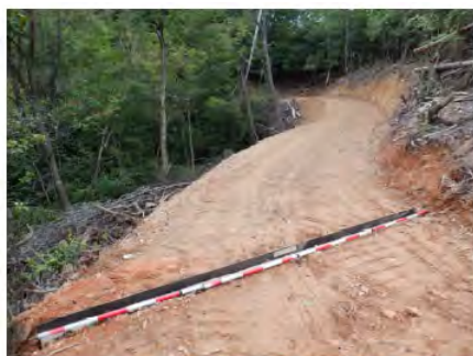
木製路面排水工 (京都府京丹波町)
