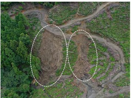
写真－６ 作業道崩落状況
