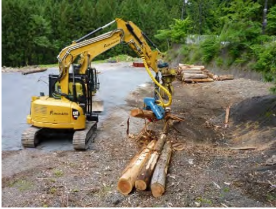
写真-13 造材作業
