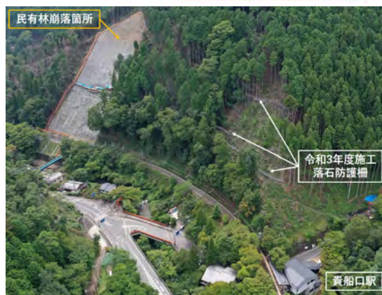
写真-23 叡山電鉄上部斜面施工後の状況
