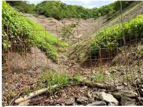
写真-12 防護柵の設置
