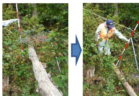
写真-3 倒木(干渉部分の除去)
