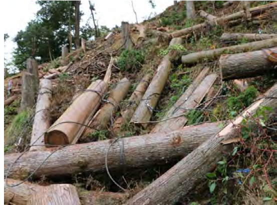
写真-10 ワイヤロープ巻き付け
