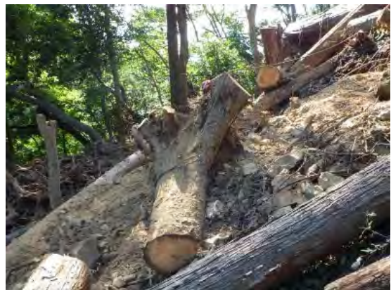
写真-17 ワイヤーロープ巻き付け
