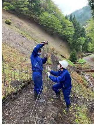
写真-3 防護柵の設置
