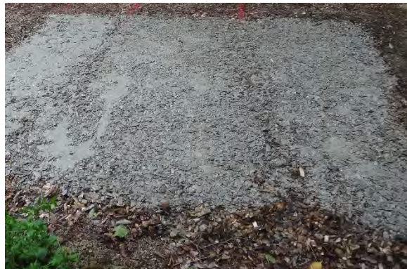
写真-6 セメント施工
