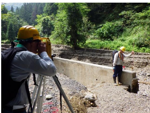
(写真：右下) 被災箇所の現地測量 (R4.8福井県大雨被害の実施例)
