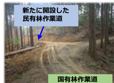
共同して整備した森林作業道
