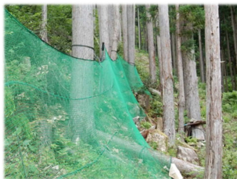
低コスト防護柵の設置
