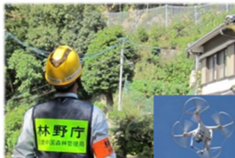
ドローンによる施設点検 (H28.10鳥取地震の実施例)
