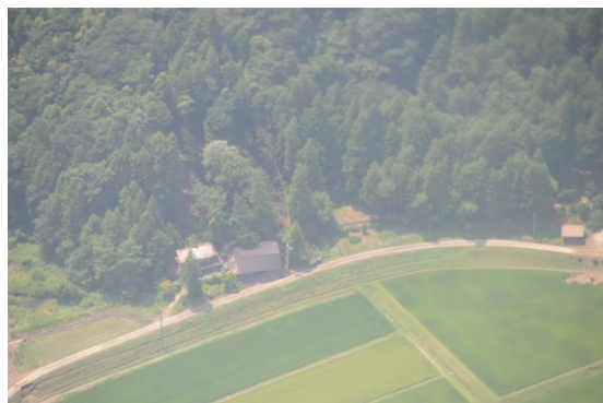
写真 16 上小川東分の地すべり的な土砂移動
