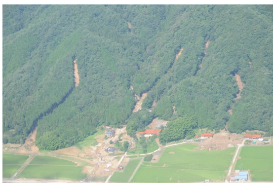
写真7 山口市嘉年下吉部野下の斜面崩壊
