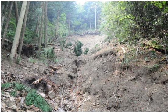
写真 11 福田上八保の斜面崩壊の源頭部
