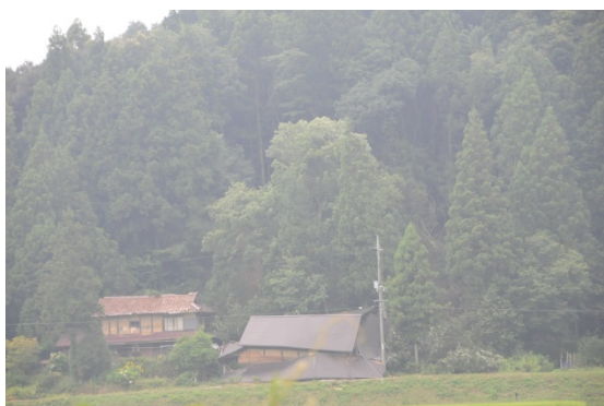
写真 17 上小川東分の地すべり的な土砂移動
