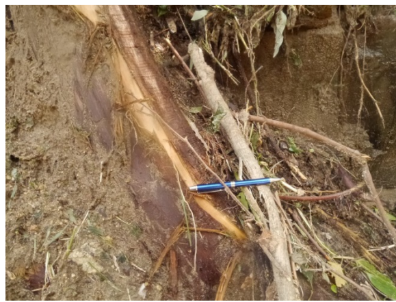
写真 18 崩壊発生斜面对岸の樹木 流水による樹皮の剥離が見られる
