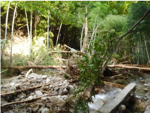
写真 19 国道 9 号線への出口付近
