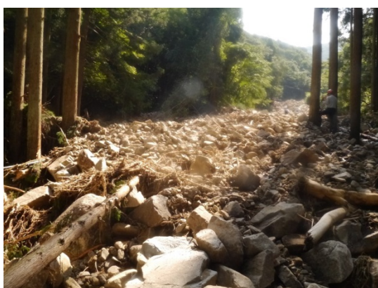
写真 13 流石川の崩壊の末端部
