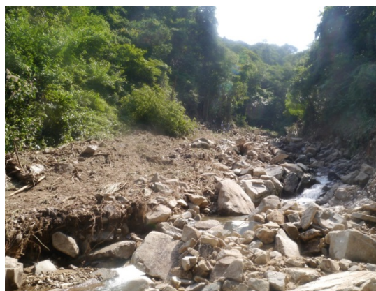
写真 16 崩壊地流下部の上流側
