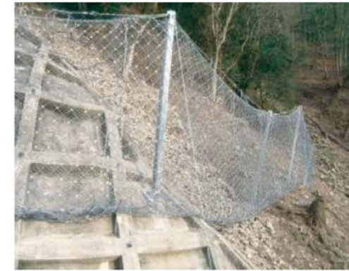
高エネルギー吸収柵の事例 (1000kJタイプ)
