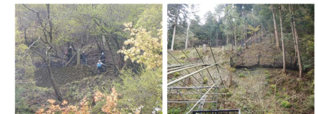
落石防護柵工
