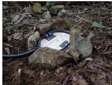
③塩ビ管の上に踏み板をセット
