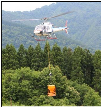
航空緑化導入工 施工イメージ
