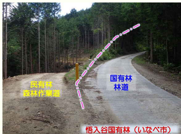
【国有林林道と民有林森林作業道の連結】
