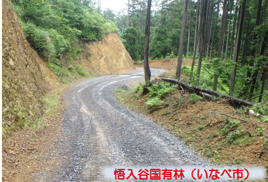
【開設した林業専用道】
