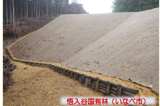
【間伐材を利用した木柵工 (林道の法尻に施工)】
