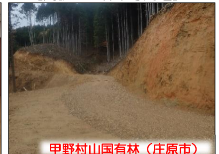
【開設した林業専用道】
