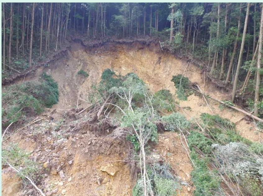
山腹工（施工前）
