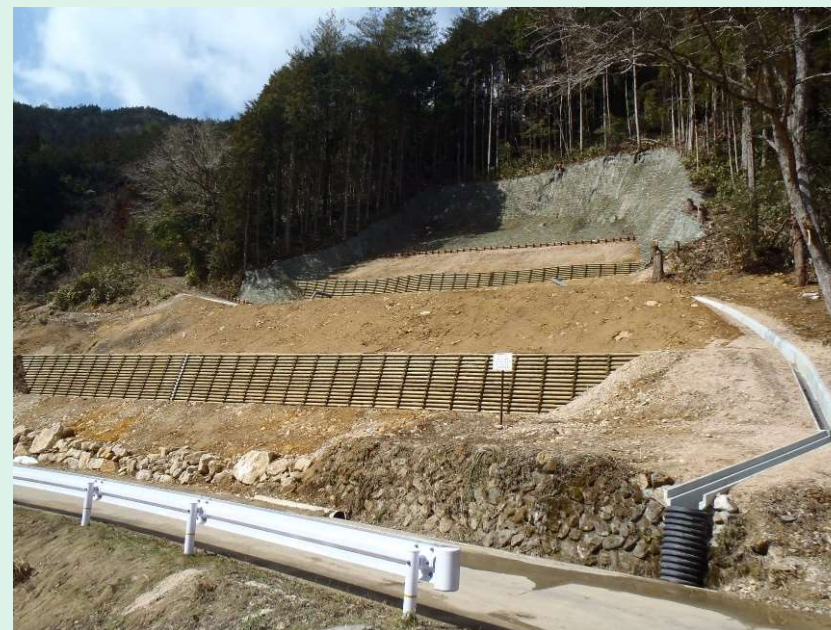
山腹工（施工後）
