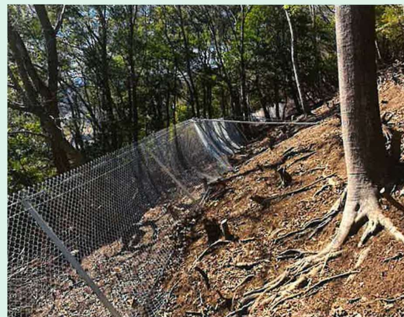
山腹工（施工後）
