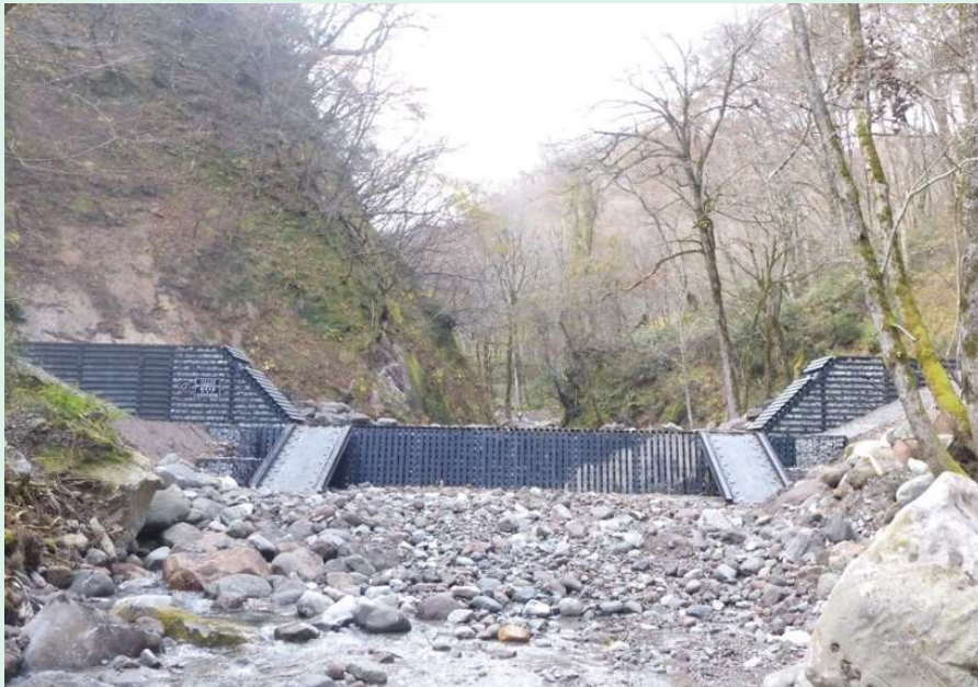
治山施設（溪間工）
