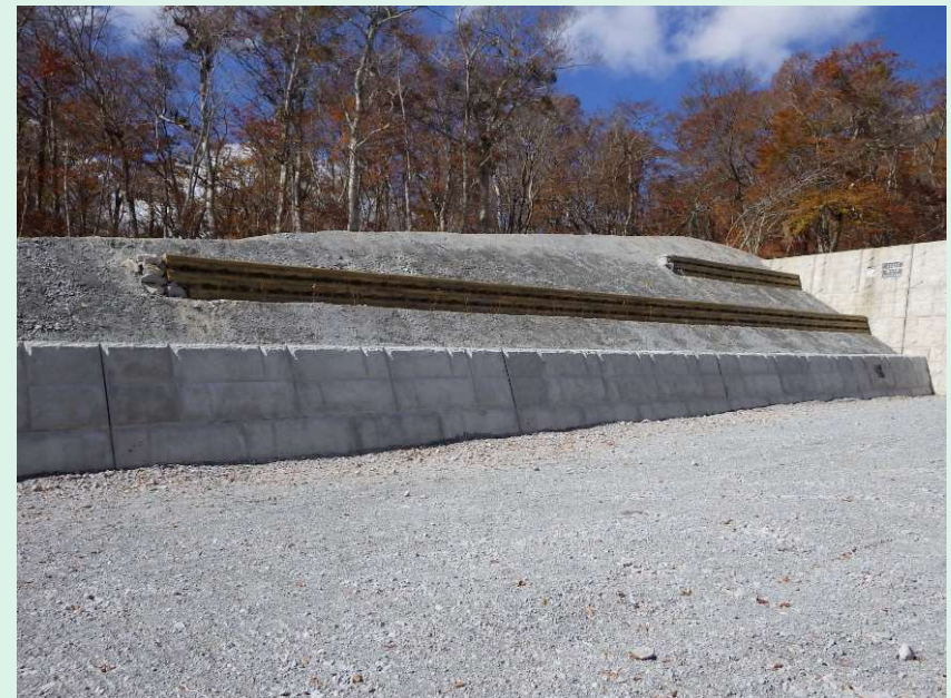
治山施設（溪間工）
