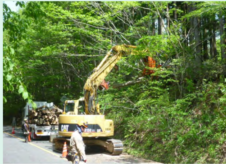
伐倒・搬出作業
