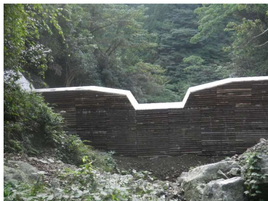
溪間工施工地 (萩：白須山国有林：阿武町)
