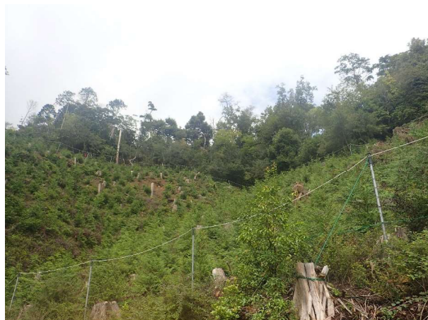
防護柵の設置 (淀川上流：安祥寺山国有林：京都市)
