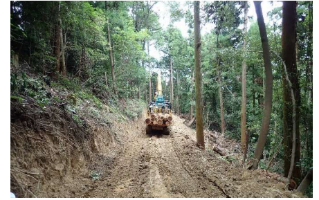
フォワーダによる運材 (湖南：奥島山国有林：近江八幡市)
