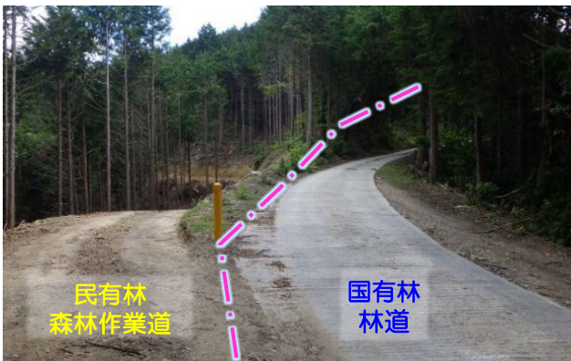
国有林から民有林内へ作設された森林作業道
