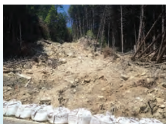
【山腹工】 災害発生の状況
