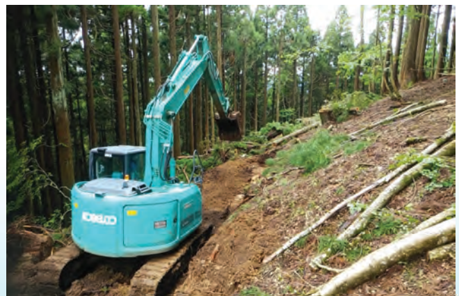
小舟山林業専用道 (若桜町)
