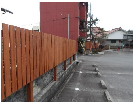
【ヒノキ材を用いた塀への改修】 (広島北部森林管理署:三次市)
