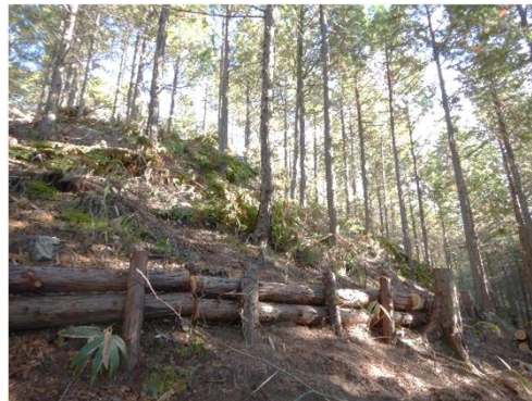
【※2 本数調整伐、丸太筋工】
