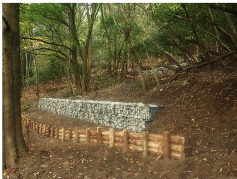
【かご枠、丸太筋工(土砂流出防止)】
