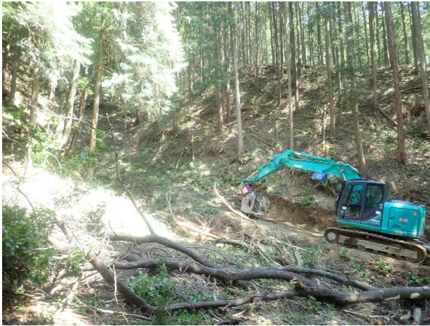
【作業道作設フェラバンチャザウルスロボ】
