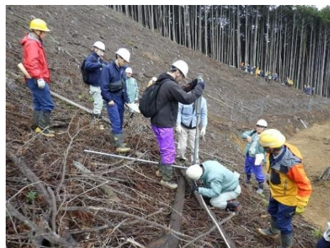
鋼製シカ柵の支柱打込み作業
