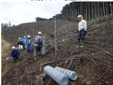
鋼製ネットの設置作業
