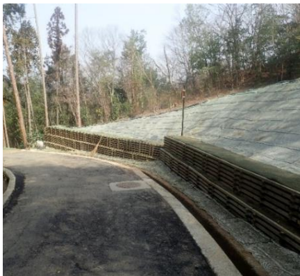
木製柵筋工(東広島市:民有林直轄治山)
