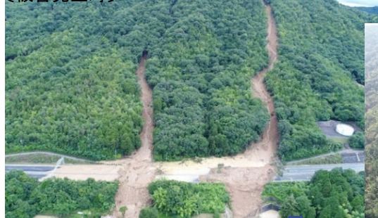
【東広島市：高屋区域】 写真下部は山陽自動車道
