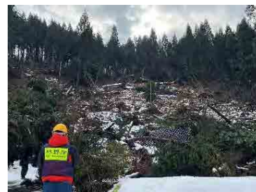
ドローンによる被害調査
