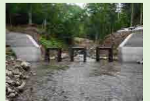
流木捕捉式治山ダム工
