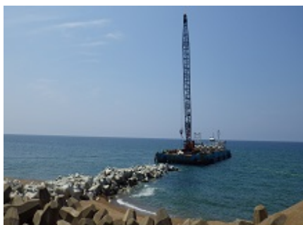
突堤工(設置風景)
