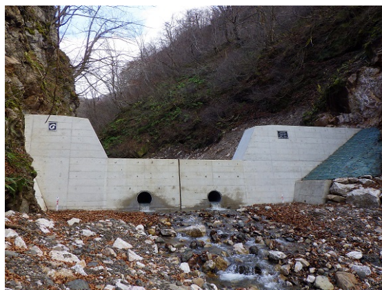
溪間工（施工後）
