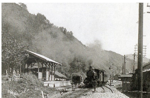
日原営林署専用のプラットホーム
