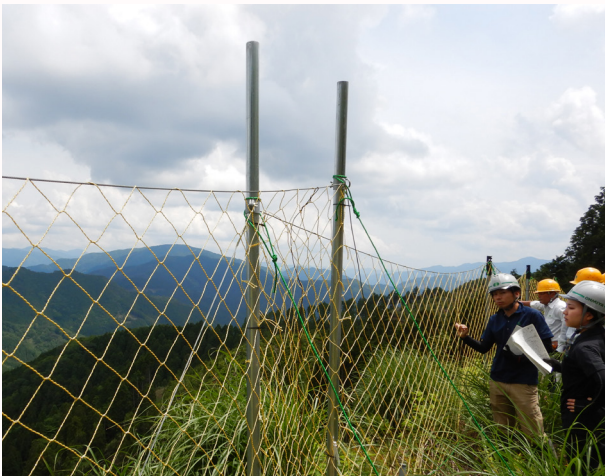
ネット継ぎ目と施工状況
