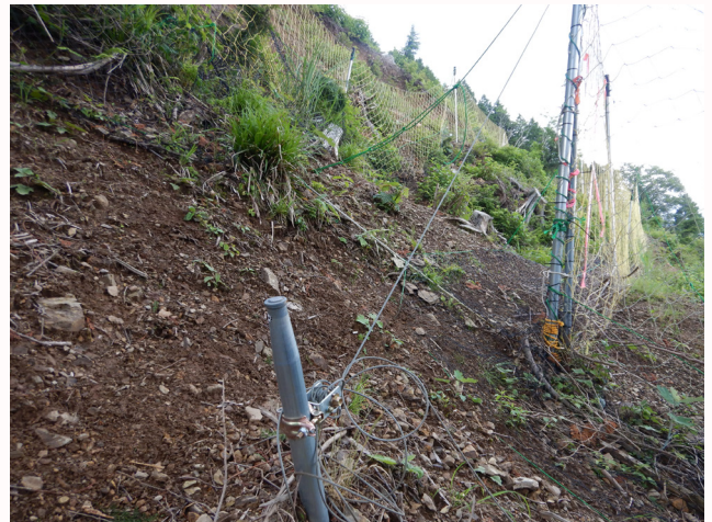
テンション機材と施工状況
