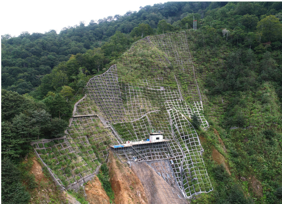
やまがせやま 山伏山山腹工事
