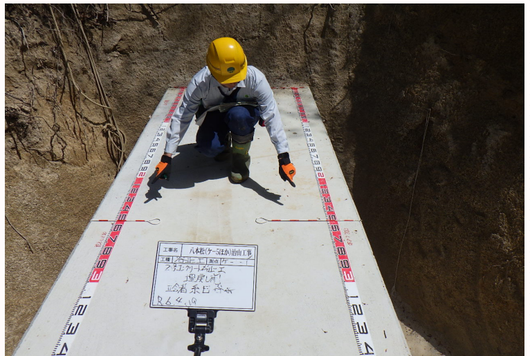
治山工事の現場での監督業務（出来形確認）の様子
