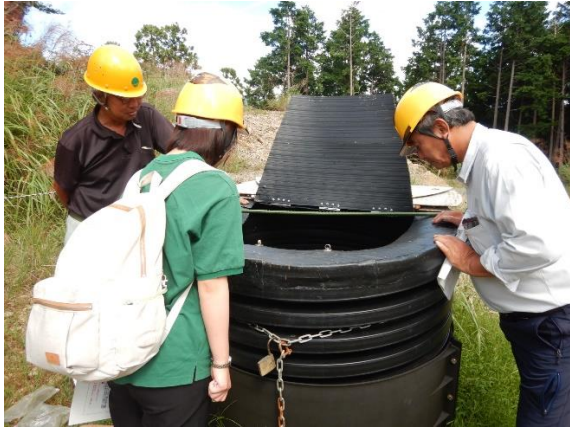
大型排水管を使用した残渣処理
