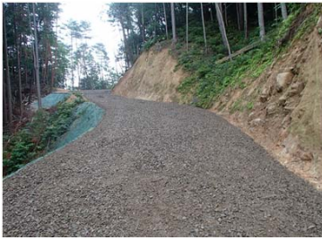
林業専用道新設
