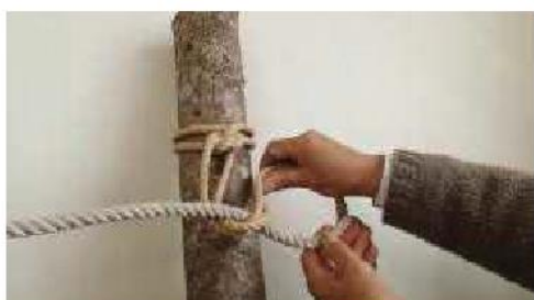
5：トックリ結び（防護柵上ロープ通す）
