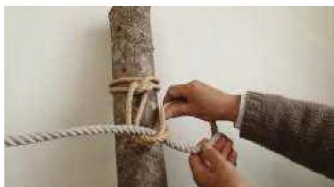
5：トックリ結び（防護柵上ロープ通す）
