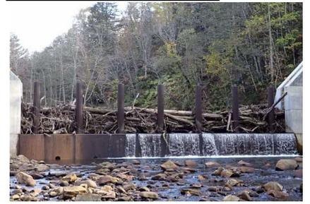
流木捕捉式治山ダムが流木を捕捉し、下流への流出を抑制（北海道名寄市）
