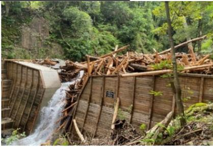
流木捕捉式治山ダムが流木や土砂を捕捉し、下流への流出を抑制（熊本県球磨村）
