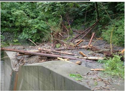
治山ダムが土砂・流木を捕捉し、国道への流出を抑制（高知県吾川いの町）
