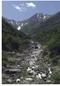
【工事実施後 (S62)】
